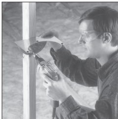
Fixer le support de montage (NB)
